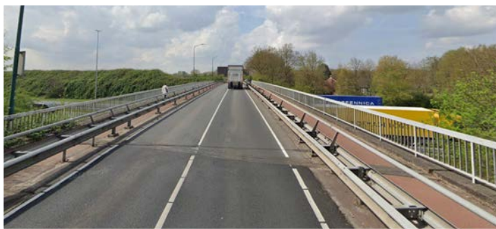
Huidige situatie viaduct over A27
