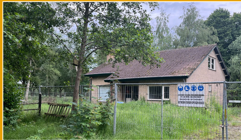
voor de sloop werkzaamheden
